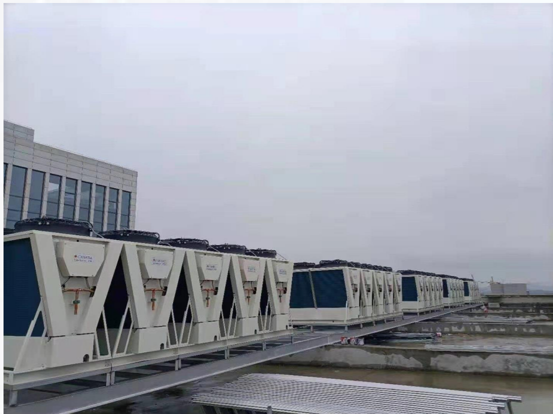
项目现场照片
